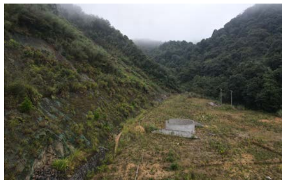
2#专用进风井现状
