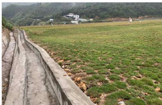
尾矿库坝肩排水沟
