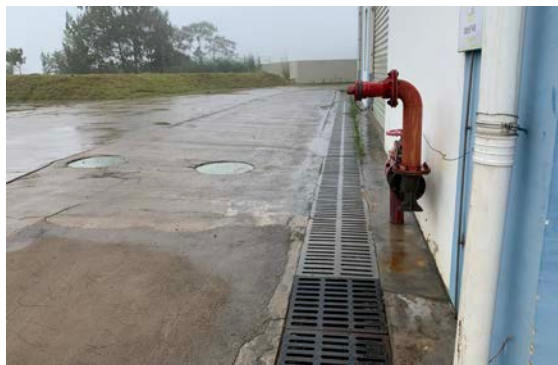
主箕斗井四周盖板沟
